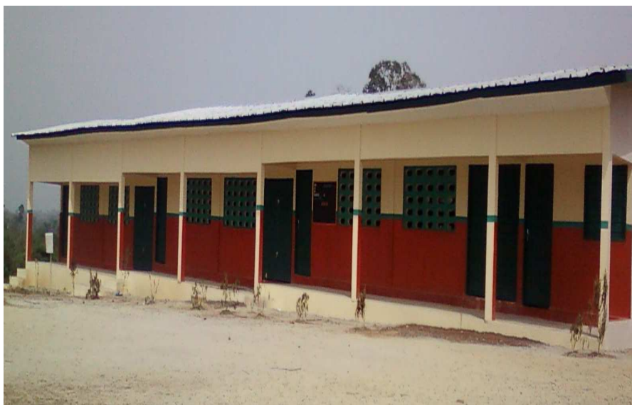
Photo 6: Une vue des classes construites à Broukro (San-Pedro)
