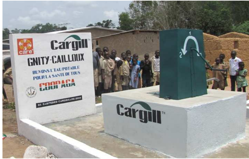
Photo 4 : Vue du puits amélioré dans la cours de l'école primaire de Gnity-Cailloux (San-Pedro)
