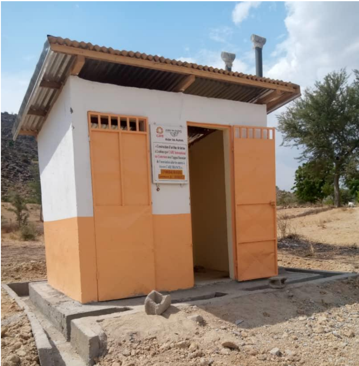
Figure 1.. Latrines construites à Mokolo dans le cadre du projet Walindé
